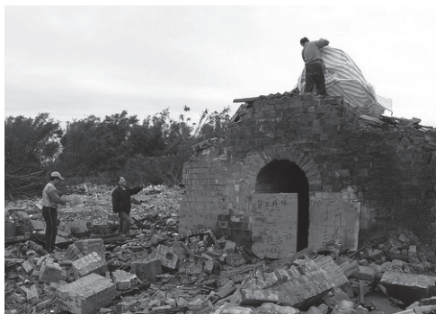
抗議古窯被拆的拆除現場。
